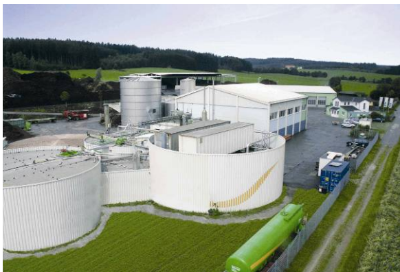
Fermenteranlage einer zweistufigen Nassvergärung für Biogut und Speisereste (BIO-Energie Schwaben GmbH)
