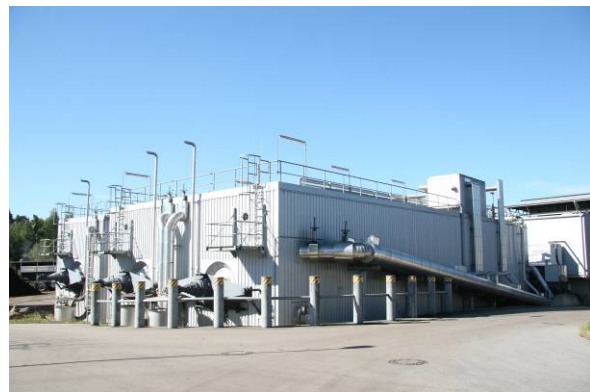
Pfropfenstromreaktor einer kontinuierlichen trockenen Vergärungsanlage für Biogut (AWG Donau-Wald mbH)
